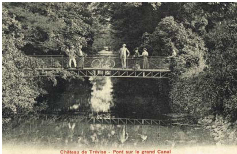
Château de Trévisé - Pont sur le grand Canal
