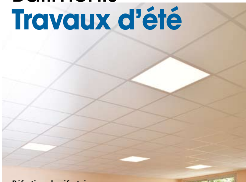
Réfection du réfectoire Monnet-Moulin : passage en éclairage LED et changement des dalles du plafond
