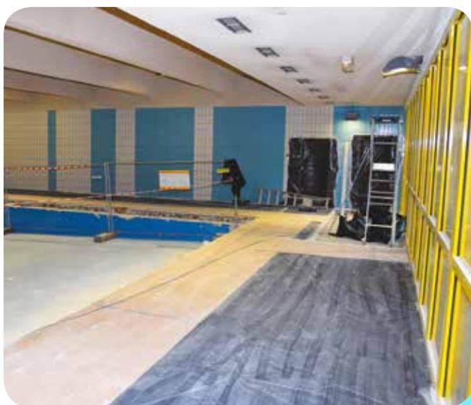
Préparation du chantier et mise en place des protections des plages du bassin
