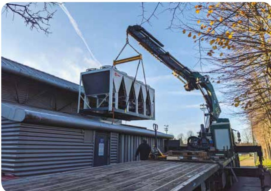
La Municipalité a donc décidé de le remplacer au profit d'un nouveau groupe de climatisation, ne nécessitant plus la présence de la tour aérorefrigérante qui posait, de surcroît, régulièrement des problèmes de maintenance.
