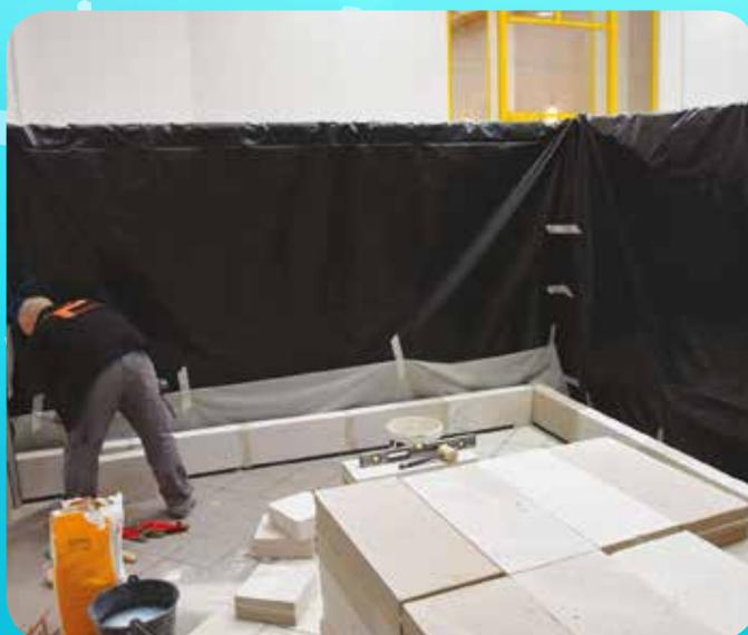
La pose du 1<sup>er</sup> rang de la maçonnerie du vestiaire et sanitaire PMR
